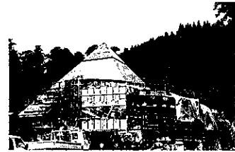
建設がすすむ展示館 (平成3年頃)
